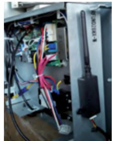
Adaptador de radio para unidad interior: debe conectarse a la tarjeta electrónica correspondiente.
